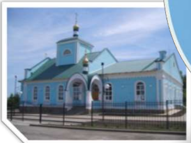
РЕКОНСТРУКЦИЯ ОБЩЕСТВЕННОГО ЗДАНИЯ в с. Подольхи Ивнянского района
