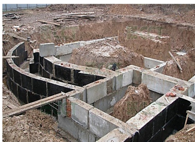
Рисунок 5.7 — Примеры ленточных фундаментов
