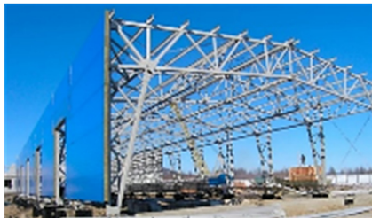
Рисунок 4.16 — Примеры применения арок и рам в одноэтажных промышленных зданиях: a — арки; б — рамы
