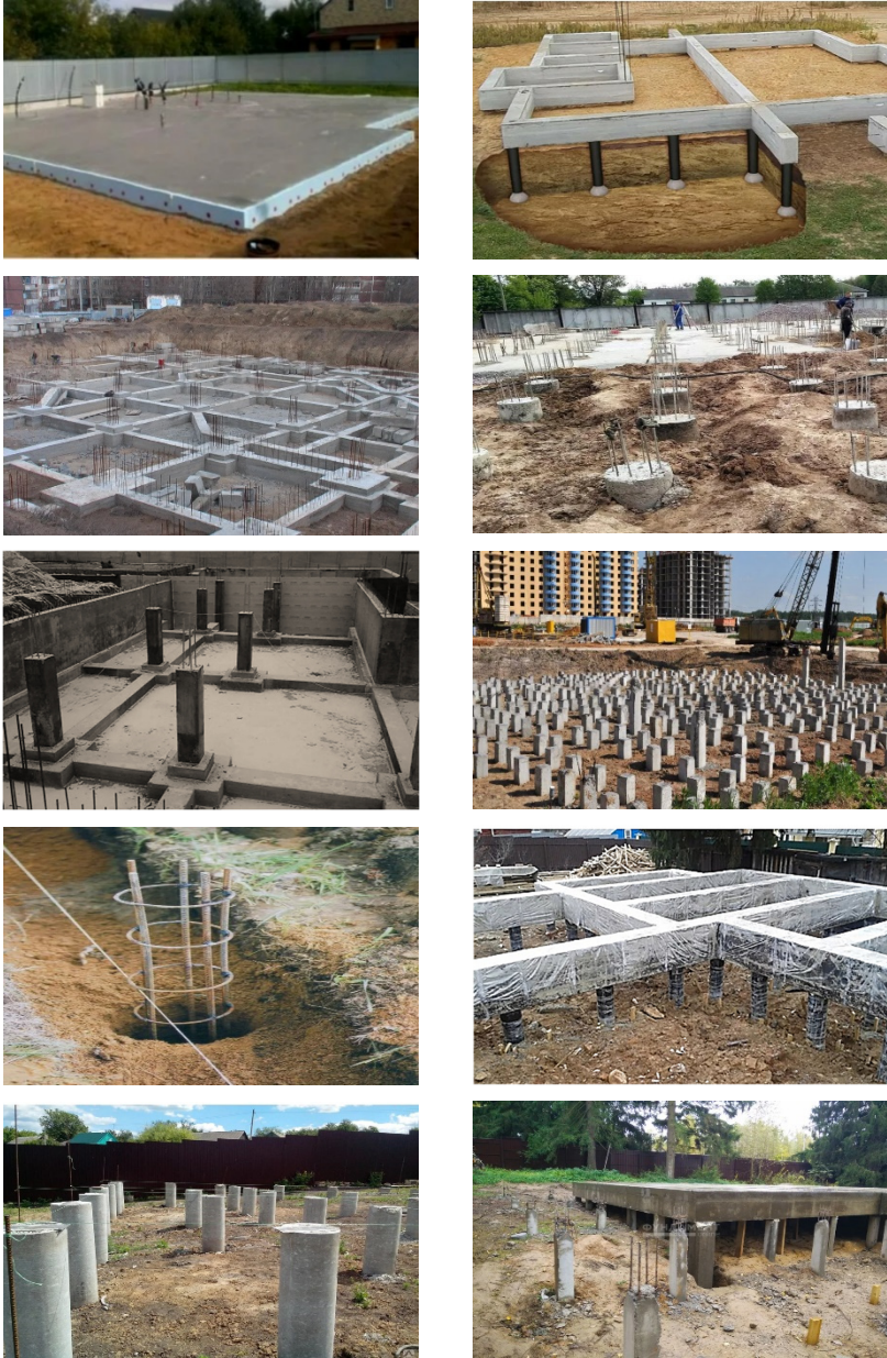
Рисунок 5.9 — Примеры сплошных и свайных фундаментов
