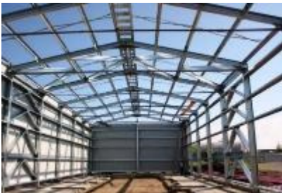
Рисунок 4.18 — Связи в промышленных зданиях: а — примеры; б — схемы решений вертикальных связей по колоннам; в — в покрытии из металлических ферм и арок
