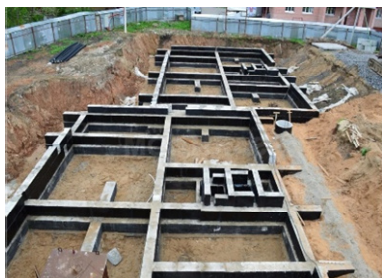
Рисунок 5.7 — Примеры ленточных фундаментов
