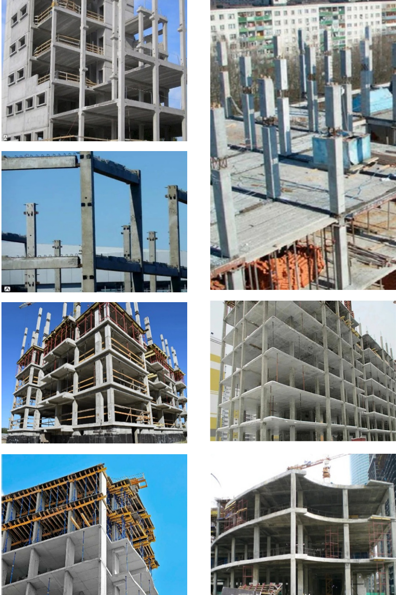
Рисунок 5.3 — Примеры железобетонных каркасов гражданских зданий
