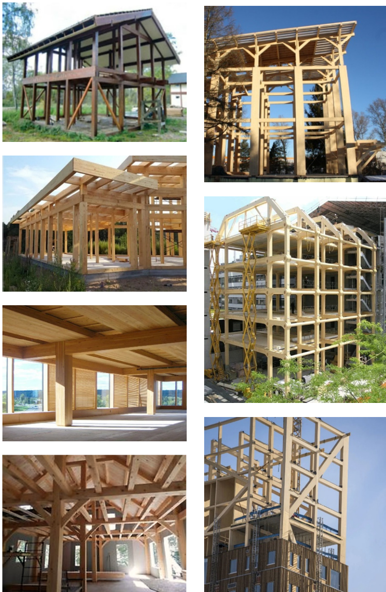
Рисунок 5.5 — Примеры деревянных каркасов гражданских зданий
