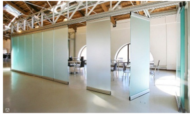
Рисунок 5.29 — Перегородки в гражданских зданиях: a — виды трансформируемых перегородок: шарнирно-складывающиеся, прямораздвижные, откатные, гармончатые; б — примеры мобильных перегородок; в — примеры трансформируемых перегородок
