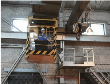
Рисунок 4.31 — Прочие конструктивные элементы промышленных зданий: a — посадочная площадка (с одномаршевой служебной лестницей); б — виды служебных лестниц (вертикальные, маршевые); в — посадочная площадка (с многомаршевой служебной лестницей); г — ремонтно-посадочная площадка (с вертикальной служебной лестницей)
