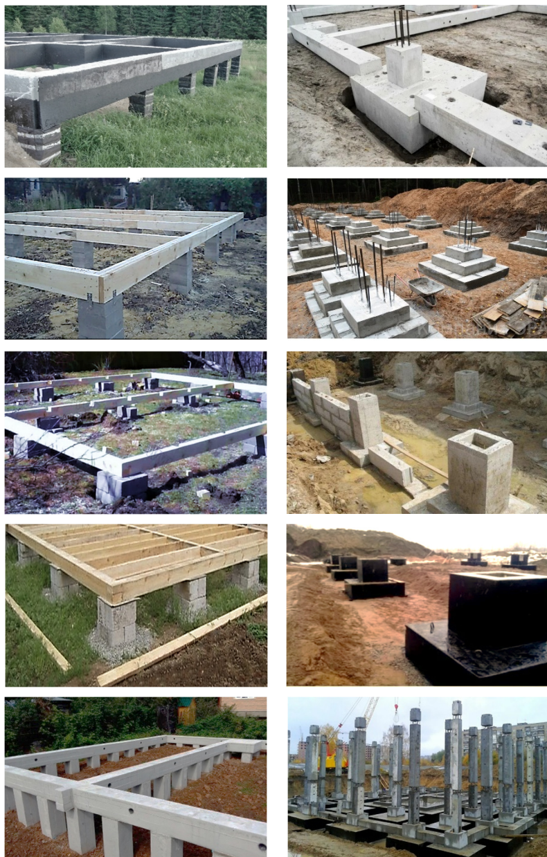
Рисунок 5.8 — Примеры столбчатых фундаментов
