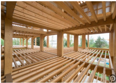
Рисунок 5.2 — Примеры балочной клетки гражданских зданий
