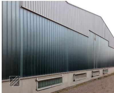
Рисунок 4.22 — Заполнение оконных проемов: а — отдельные проемы; б — ленточное остекление; в — сплошное остекление; г — схемы заполнения оконных проемов; д — переплетное и безпереплетное; е — сечения профильного стекла (стеклопрофилита); ж — пример заполнения проемов стеклопрофилитом
