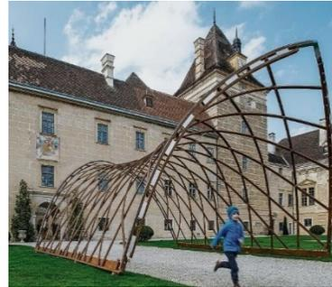
Рисунок 2.18 — Примеры моделей гиперболических параболоидных навесов
