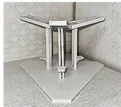
*Рисунок 2.29* — Теневой навес из клееных деревянных конструкций и влагостойкой фанеры. Выполнила Шопина Е.
