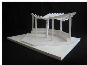
*Рисунок 2.27* — Теневой навес из клееных деревянных конструкций.
