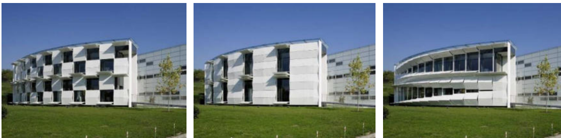
Рисунок 68 — Примеры симметричных преобразований: а — композиция из бумаги с разверткой для построения; б — здание с динамическим фасадом «Kiefer Technic Showroom» в Бад-Глайхенберге (Австрия), 2007 г., арх.: Giselbrecht + Partner ZT GmbH
