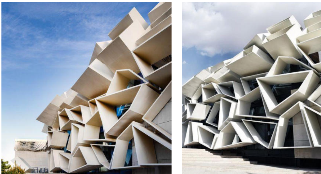
Рисунок 164 — Выставочный павильон «Greenland Convention Center» в Садре (Иран), 2015 г., арх.: Mehrdad Iravanian Architects
