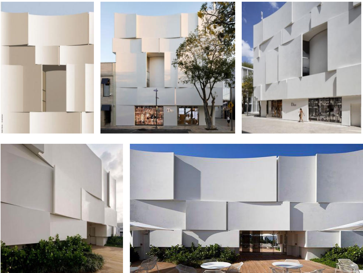
Рисунок 66 — Решение фронтальной поверхности фасадов бутика Dior в Майами (США), 2016 г. арх.: Barbarito Bancel Architects
