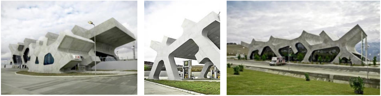
Рисунок 162 — Объемно-пространственная композиция сооружений с членениями объемной формы сложного стереометрического очертания: автозаправочные станции в стиле брутализм на автотрассе Турция-Азербайджан (Грузия), 2011 г., арх.: J. Mayer H. und Partner
