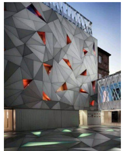
Рисунок 63 — Решение фронтальной поверхности из алюминиевых панелей здания музея в Мадриде (Испания); арх.: Aranguren & Gallegos Architects
