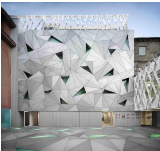
Рисунок 63 — Решение фронтальной поверхности из алюминиевых панелей здания музея в Мадриде (Испания); арх.: Aranguren & Gallegos Architects
