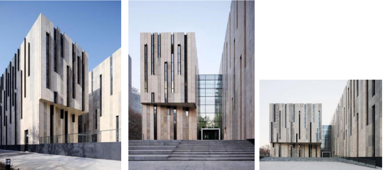
Рисунок 106 — Объемные композиции зданий из простых геометрических форм: a — общественное здание EHUNDURA в Нанте (Франция), 2011 г., арх.: Leibar-Seigneurin; б — отделение непрерывного ухода Джусо в г. Кашкайш (Португалия), 2012 г., арх.: SARAIVA and ASSOCIADOS; в — Художественный музей провинции Цзянсу г. Нанкин (Китай), 2006—2010 гг., арх.: KSP Jürgen Engel Architekten
