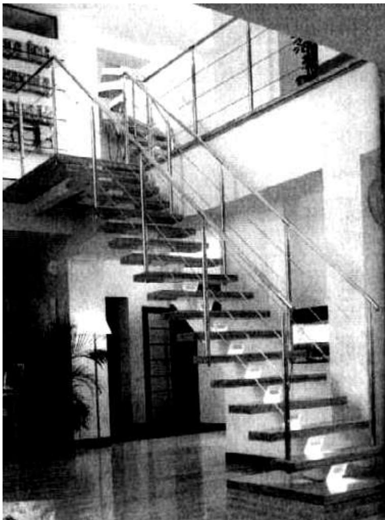
*Рисунок 54* — Внутриквартирная (в общей комнате) одномаршевая лестница с одним несущим ребром и ступенями без подступенок
