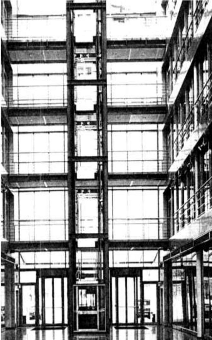
*Рисунок 76* — Стеклопанельная кабина лифта в стальном каркасе шахты
