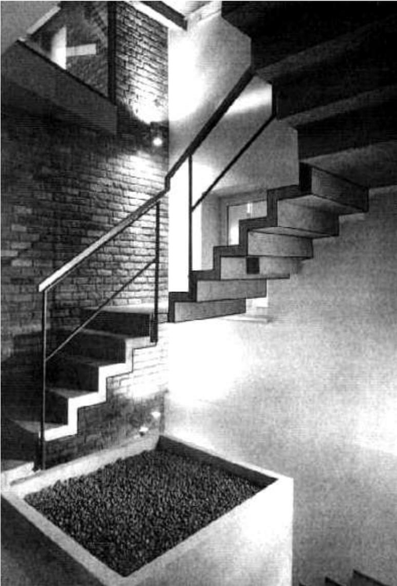
*Рисунок 55* — Монолитная железобетонная лестница в офисе.
